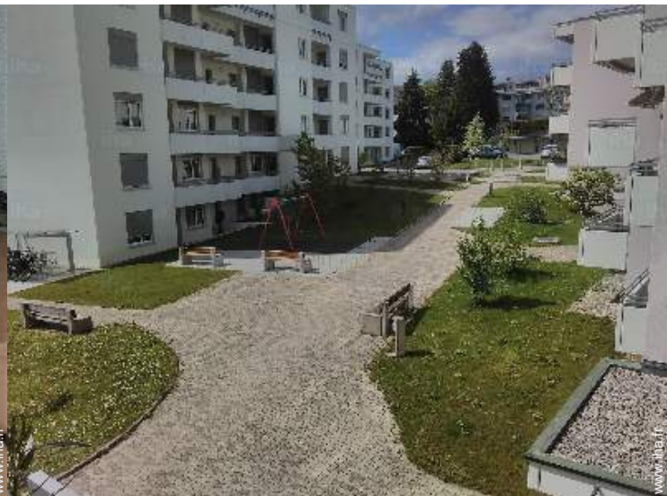
vue sur rue/avenue
