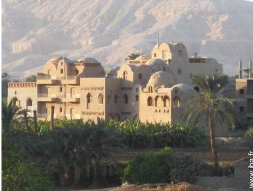
vue depuis la terrasse sur toit
