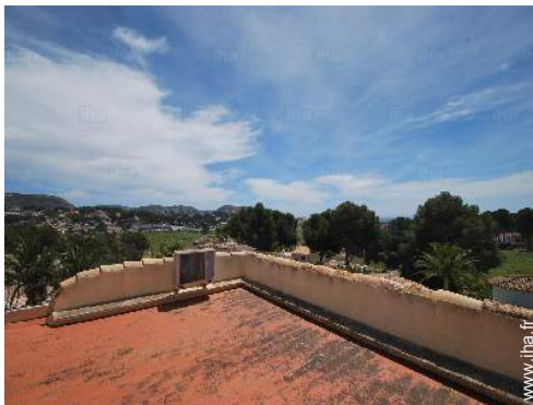
vue depuis la terrasse sur toit
