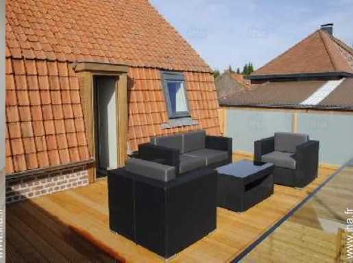
terrasse sur toit
